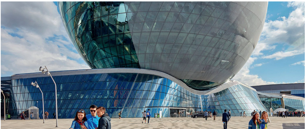
Рис. 17. Остекление криволинейной поверхности фасада здания
